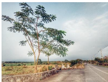
圖 15 東港溪河堤自行車道 資料來源：本小組
